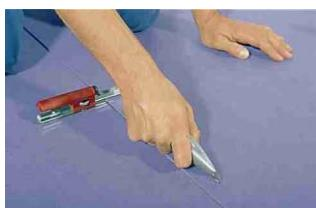
Стыки следует прирезать таким образом, чтобы края плотно подходили друг к другу, но не сдавливались и не были в распор. Обрезка стыков происходит слегка наклонно, чтобы листы соприкасались острыми верхними кромками, т.к. при расширении линолеума в поперечном направлении, острые кромки соприкасаются или даже несколько сминаются, образуя плотный шов. Концы длинных полос прирезаются после посадки на клей.
