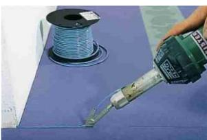
Выступающая после сварки часть шва срезается в два приёма: сначала до полного остывания с помощью серповидного ножа с опорными салазками, а затем после остывания заподлицо с поверхностью.
