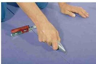
Стыки следует прорезать таким образом, чтобы края плотно подходили друг к другу, но не сдавливались и не были в распор. Обрезка стыков происходит слегка наклонно, чтобы листы соприкасались острыми верхними кромками, т.к. при расширении линолеума в поперечном направлении, острые кромки соприкасаются или даже несколько сминаются, образуя плотный шов. Концы длинных полос прорезаются после посадки на клей.
