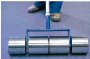
Разделку и сварку швов можно производить только после полного схватывания клея. В зависимости от марки клея (см. также рекомендации производителя клея), температуры и влажности помещения, этот процесс может продолжаться несколько дней.
